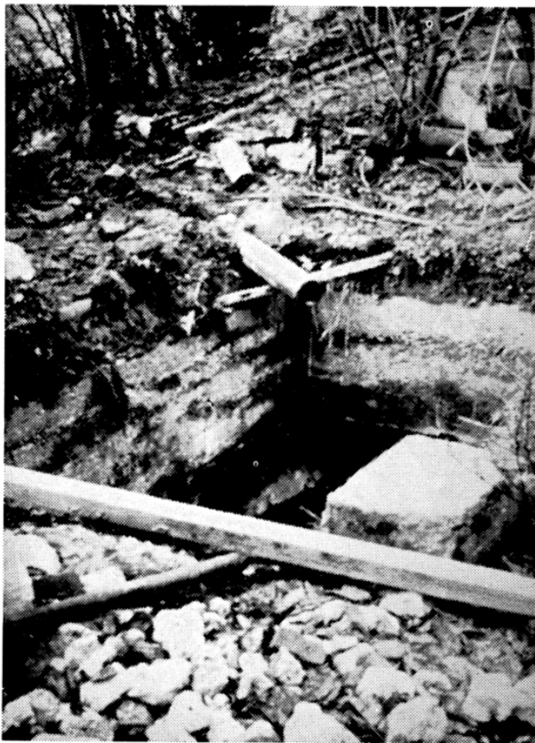
Grubenschacht der Gnade Gottes bei Bommersheim; die Grube ist stillgelegt und der Schacht aufgefüllt.
